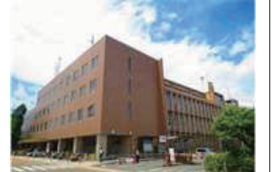
写真3. 築52～69年の現庁舎
